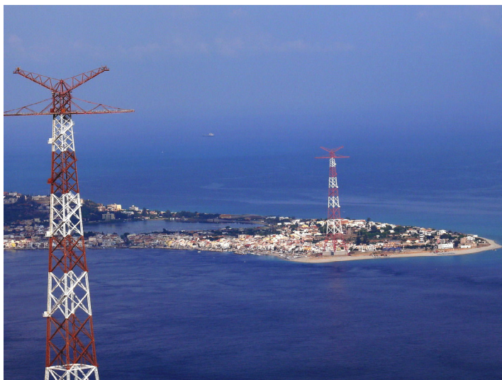
Figura 14 -Condizione attuale dei piloni.
