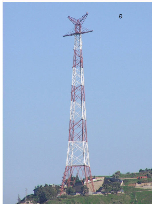
Figura 5 - Piloni della campata di attraversamento: a) lato calabro; b) lato siculo.
