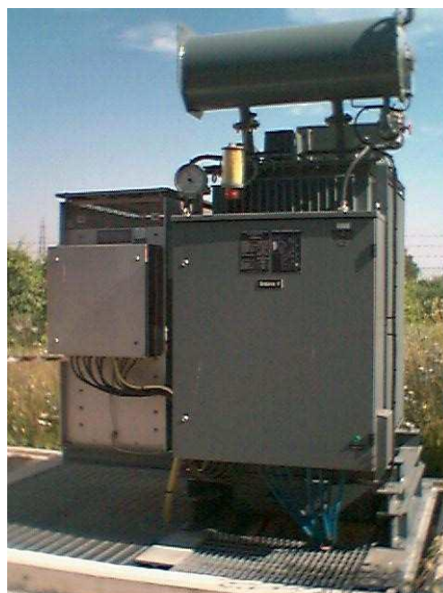
Figura 7 - Bobina mobile a regolazione continua 60 ÷ 300 A (fonte Enel).
