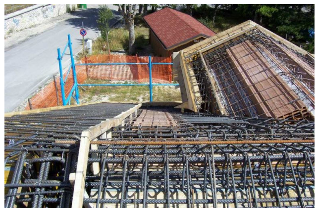
Figura 10 -Tetto in cemento armato le cui armature costituiscono di fatto una Gabbia di Faraday.
