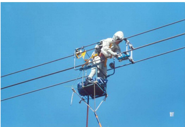
Figura 9 - Operatore con tuta protettiva al lavoro su una linea a 500 kV in esercizio
